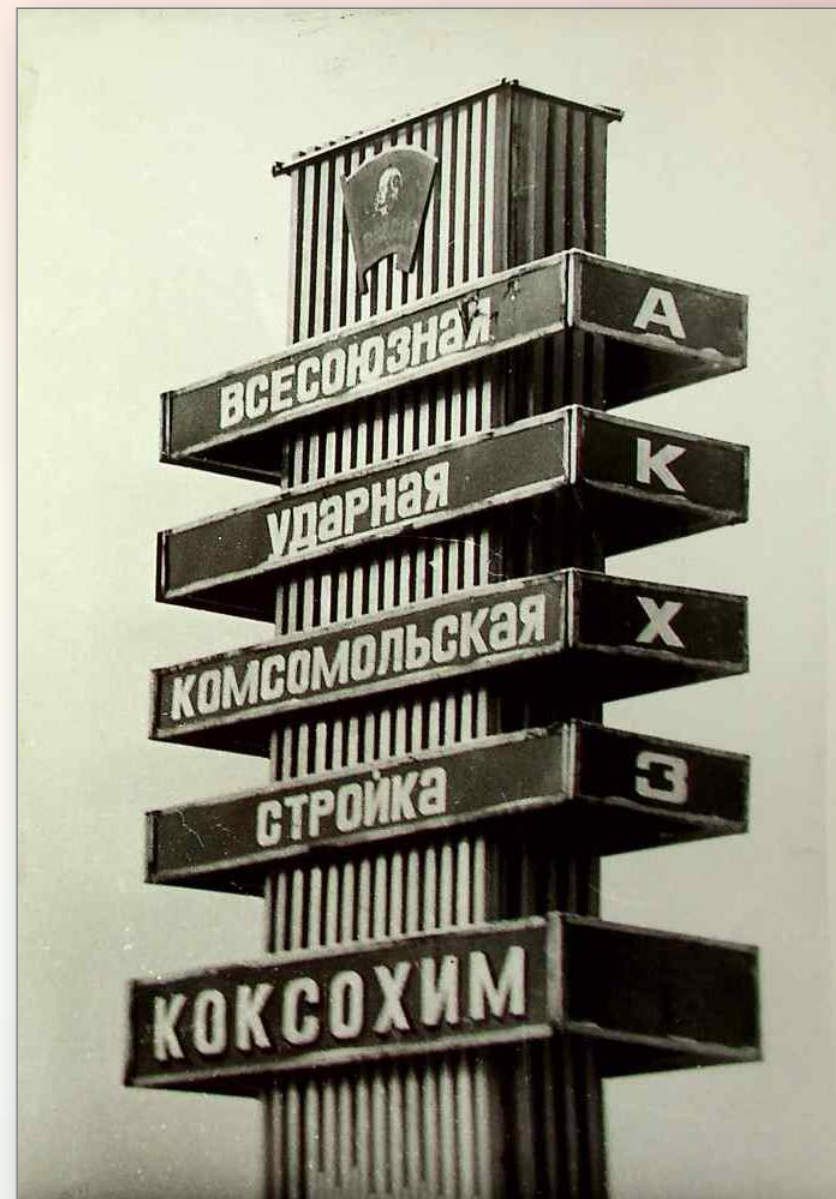
Установка знака «Здесь будет построен Алтайский коксохимический завод». 1972г.
