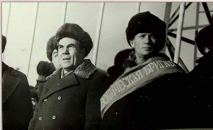
Символическая бригада по пуску первой коксовой батареи АКХЗ. 1981г.
