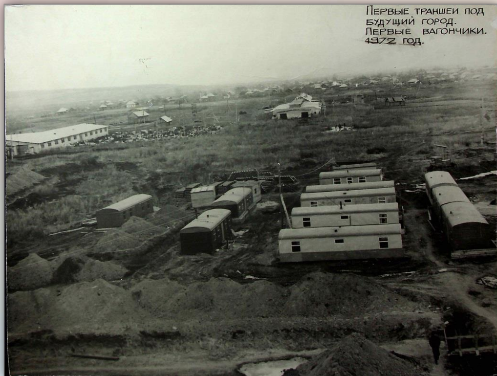
Первые траншеи под будущий город. Первые вагончики. 1972г.
