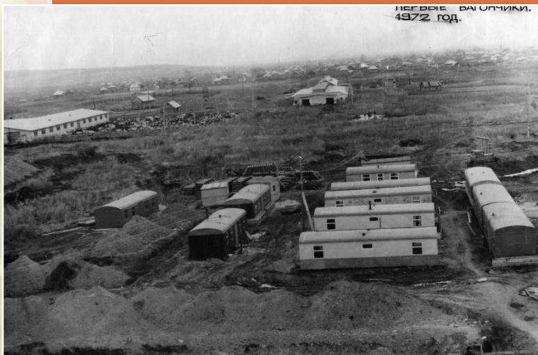
Здесь будет город. Первые траншеи, первые вагончики. 1972 Коллекция фотодокументов. Ф. 1. Оп. 1. Д. 93
