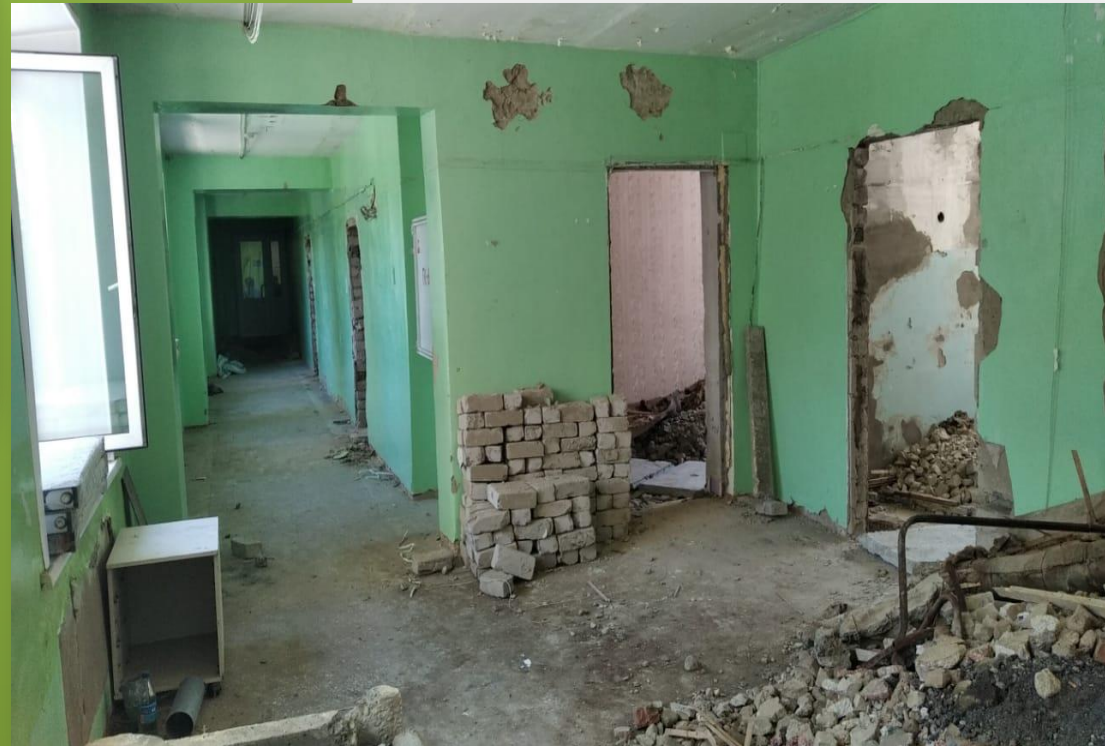
Вид на административные помещения на этапе демонтажа старого оборудования при проведении капитального ремонта городской поликлиники. 2020 год
