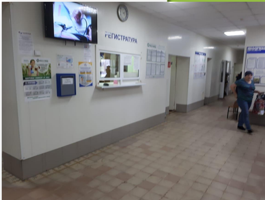
Холл городской поликлиники до капитального ремонта. 2019 год Ф.1. № 1223
